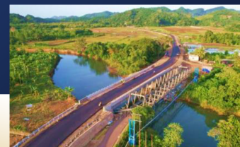
Nanga Na'e Bridge
