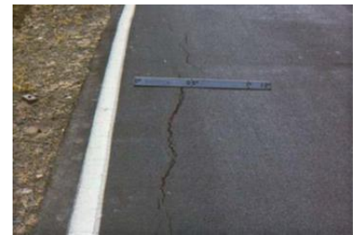
Longitudinal cracking
