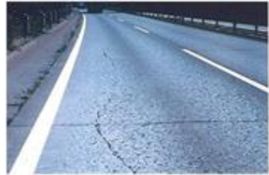
Longitudinal cracking
